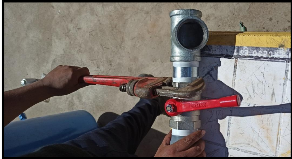
Figura 46: Ajuste necesario con ayuda de una llave stillson.
