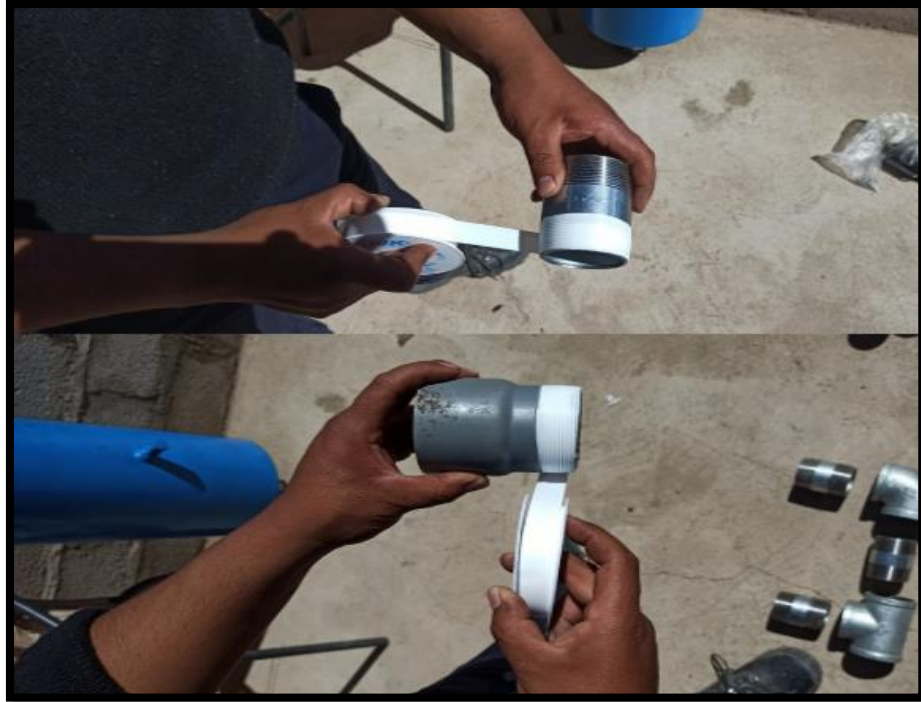
Figura 44: Colocación de teflón en las uniones roscadas.
