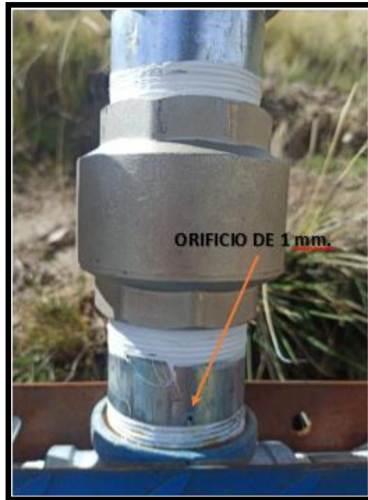
Figura 41: Orificio de 1mm (recuperador de aire)
