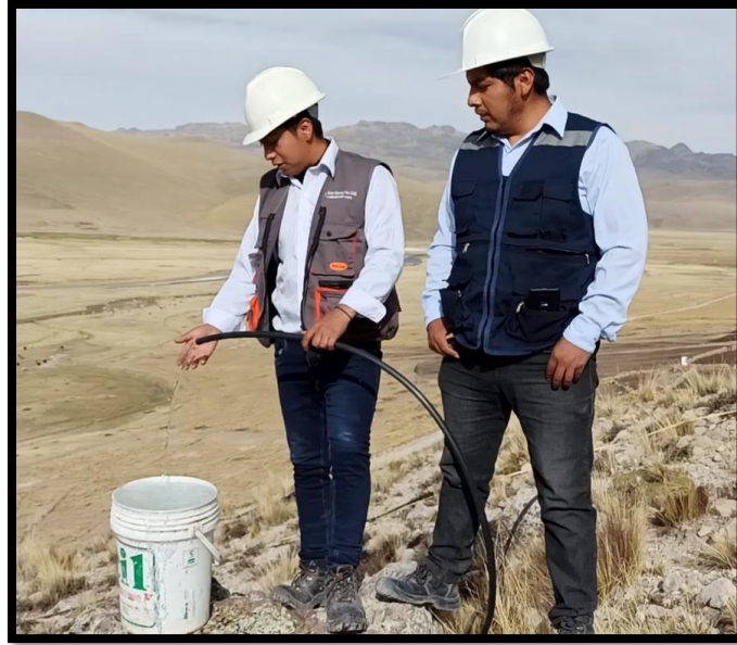
Figura 68: Entrega de agua a 35 metros de altura respecto a la bomba de ariete.
