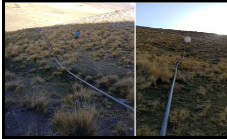
Figura 61: Instalación de la línea de suministro.
