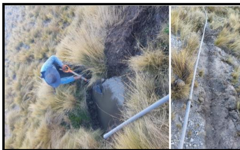
Figura 59: Captación e instalación de la línea de conducción.
