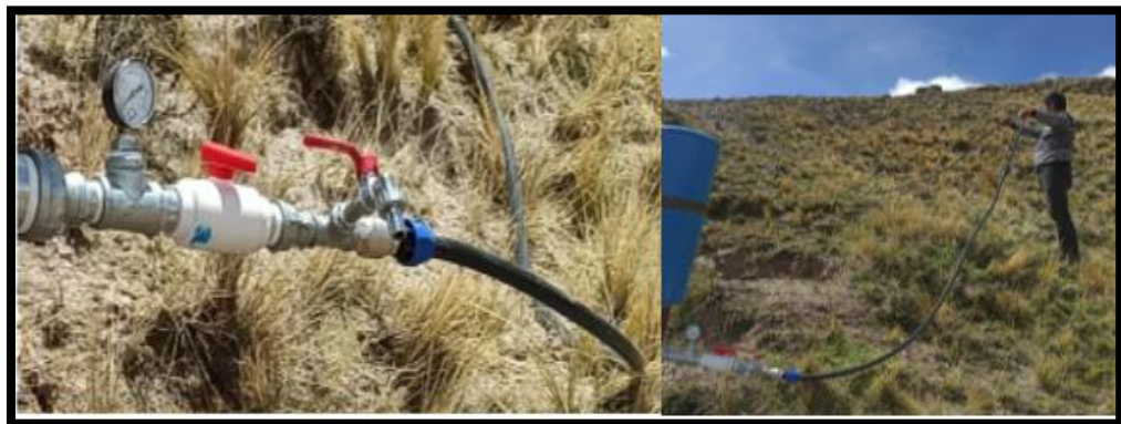
Figura 64: Instalación de la línea de descarga.
