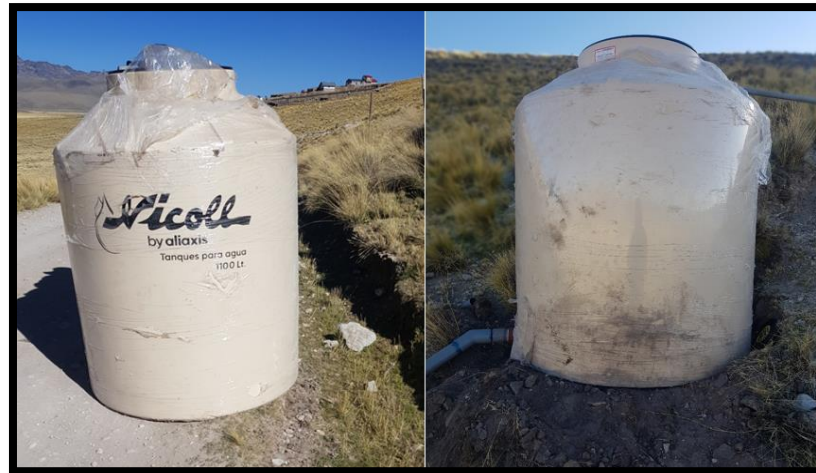
Figura 60: Instalación de la cámara de carga.
