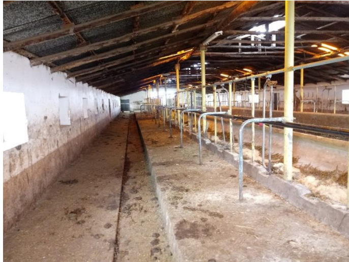
Ilustración 10 Acondicionamiento del Establo San Juan
