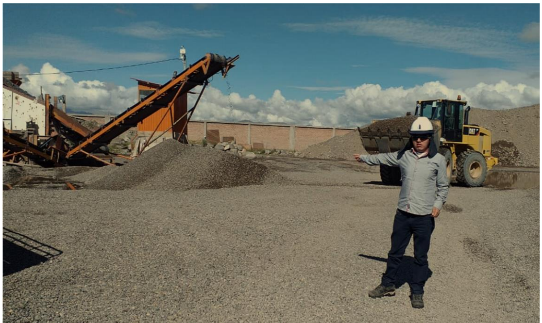
Figura 3.1: Planta procesadora de piedra chancada
