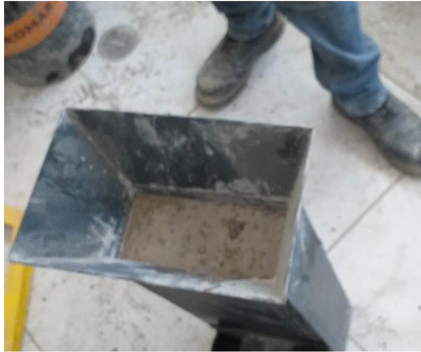
Figura 05: Terminado de llenado de caja L con concreto autocompactante.
