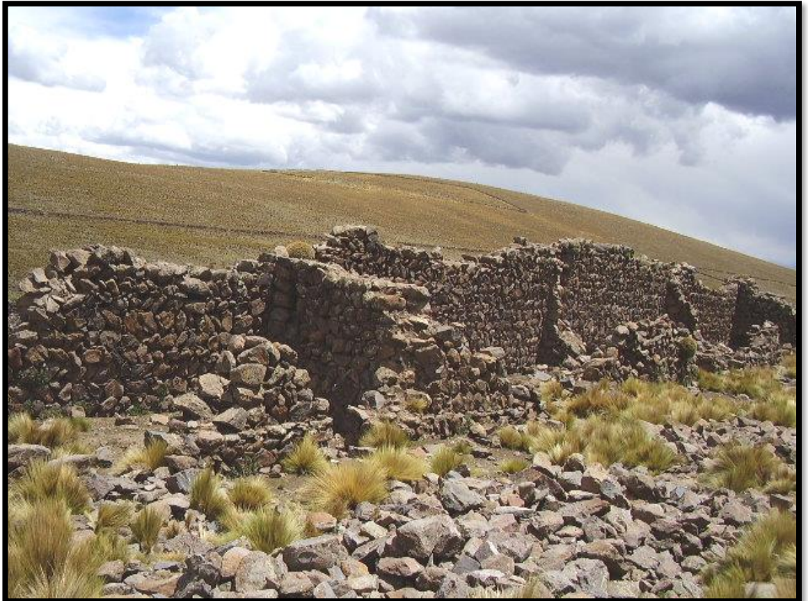
Figura 21 Vivienda de los Salcedos destruido
