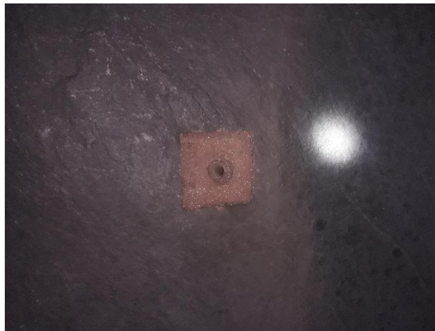
Figura 12. Sostenimiento activo con Splitset galería 495-W, manto 12, NV. 4960.
