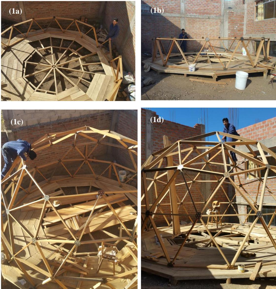
(1a) Construcción del piso base con un diámetro de 5 m. (1b) Ensamblaje del primer nivel conformado por secciones triangulares. (1c) Ensamblaje del tercer y cuarto nivel conformado por secciones triangulares. (1d). Ensamblaje del 5 nivel
