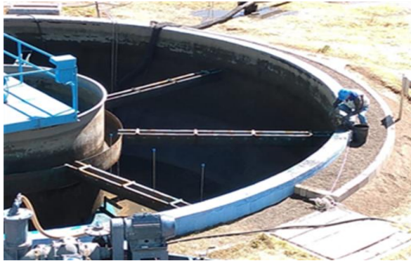
IMAGEN N° 01. Realizando la toma de muestras de lodo, de la unidad compacta N° 02.
