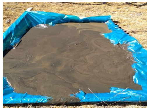
IMAGEN N° 02. Se extendió y acondiciono plástico en el suelo, con la finalidad de verter el lodo sobre ella y posterior secado natural.
