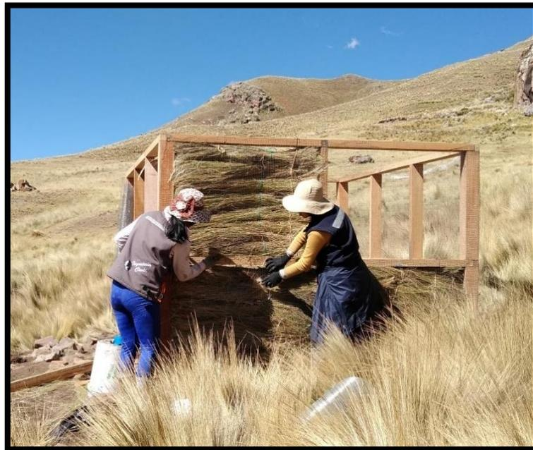
*Figura 36: Colocación del tejido en la estructura de madera.*
