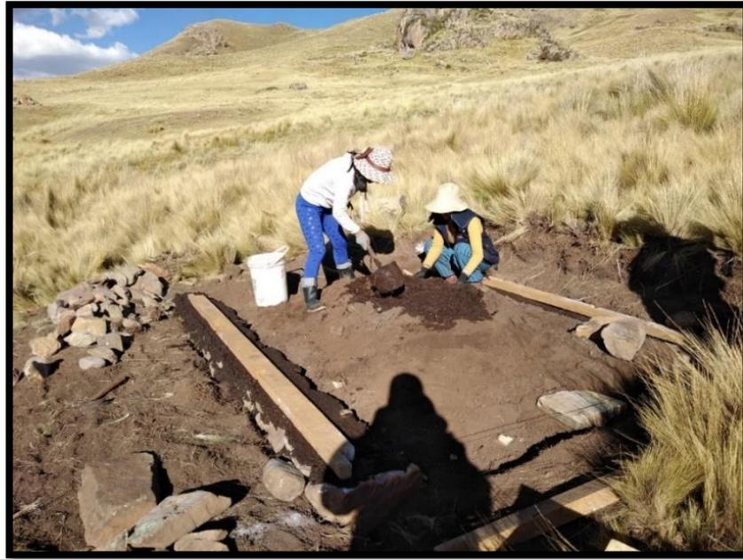
*Figura 30: Mezcla de mortero de barro para rellenar los espacios vacíos en la cimentación.*
