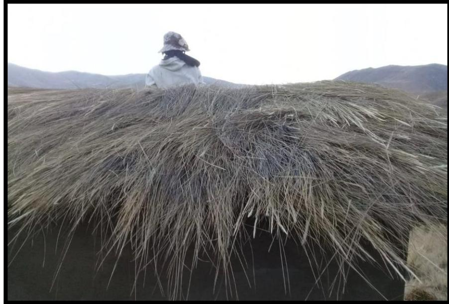
*Figura 47: colocado de la capa final a base de Stipa Ichu.*
