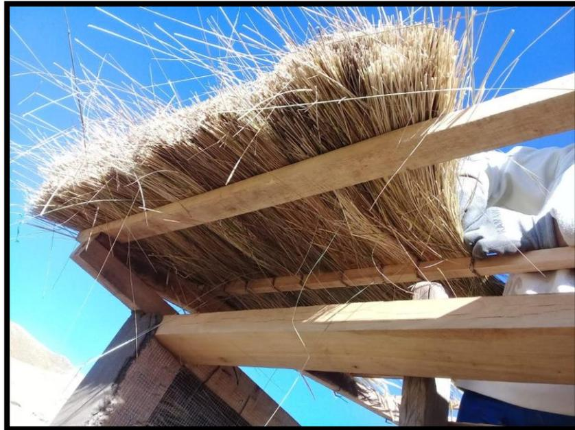
*Figura 44: Tensado del Stipa Ichu con la cuerda.*
