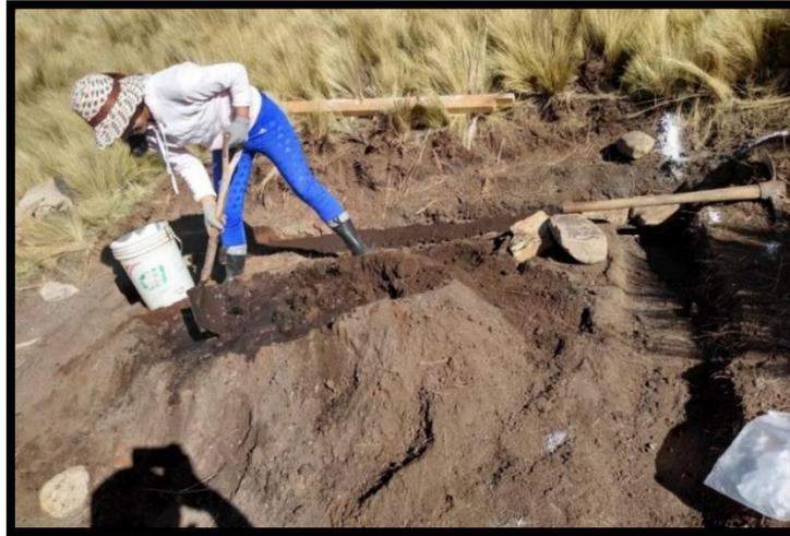
*Figura 28: Preparado de mezcla para rellenar los espacios vacíos.*
