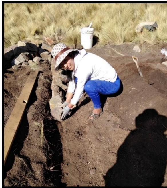
*Figura 27: Colocado de piedra mediana, en la zanja de cimentación.*
