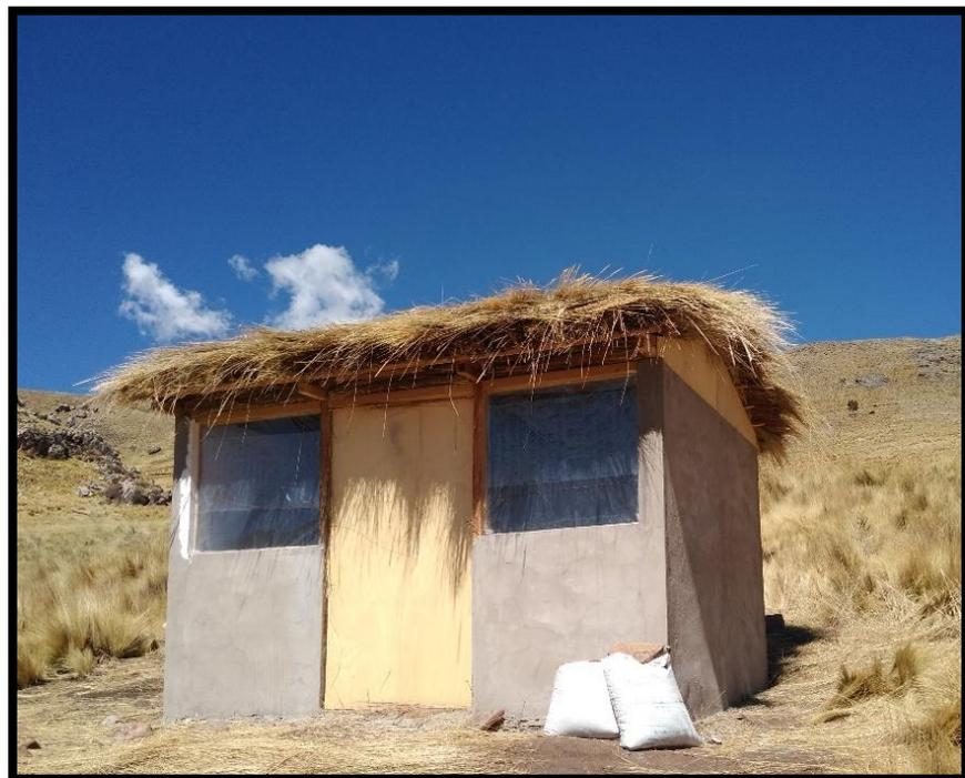
*Figura 52: Vivienda construida con tabiquería bioclimática stipa ichu.*
