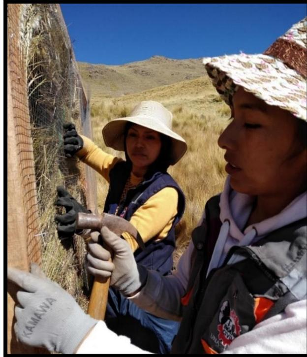
*Figura 37: Empleando clavo de 1", para fijar la malla de acero galvanizado.*
