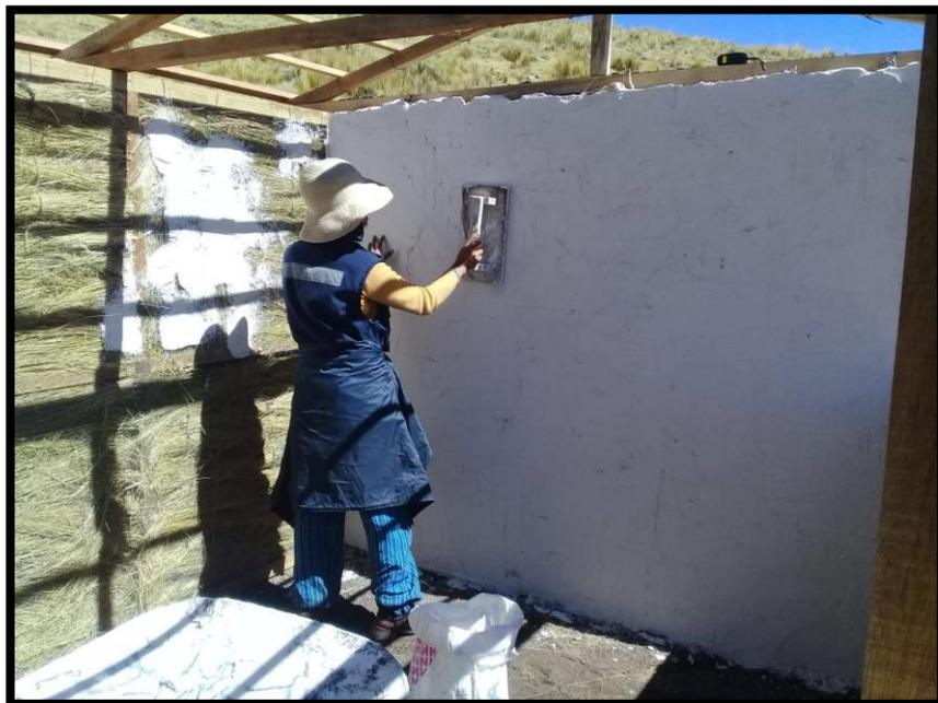
*Figura 41: Nivelación del tarrajeo interior con yeso.*
