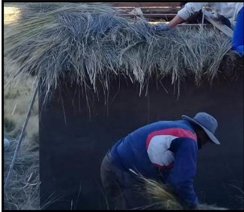
*Figura 46: Colocado del Stipa Ichu en los laterales derecho e izquierdo de la vivienda.*
