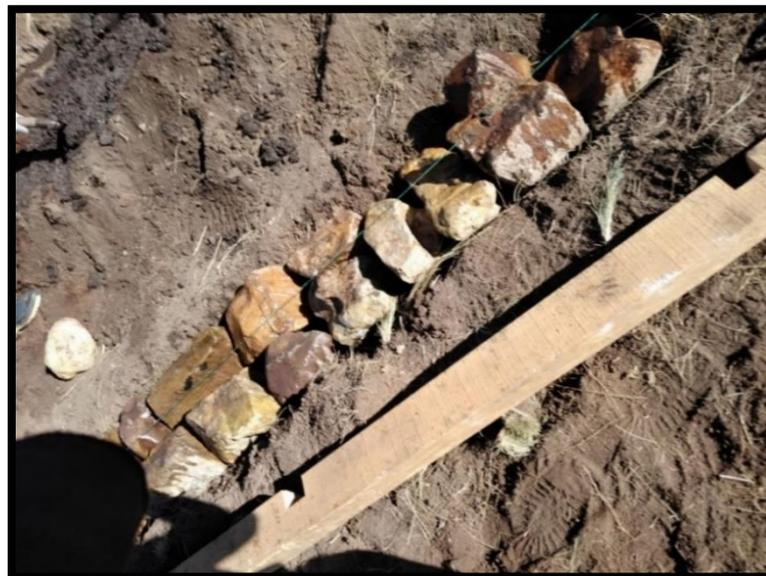
*Figura 29: Humedecimiento antes de cubrir con la mezcla de mortero de barro.*
