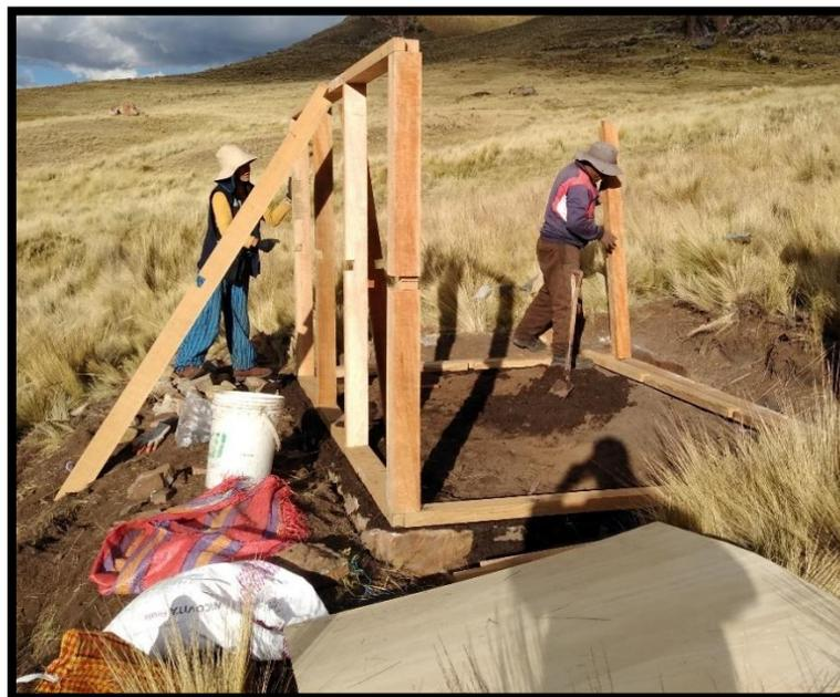
*Figura 35: Armado de la estructura de madera.*
