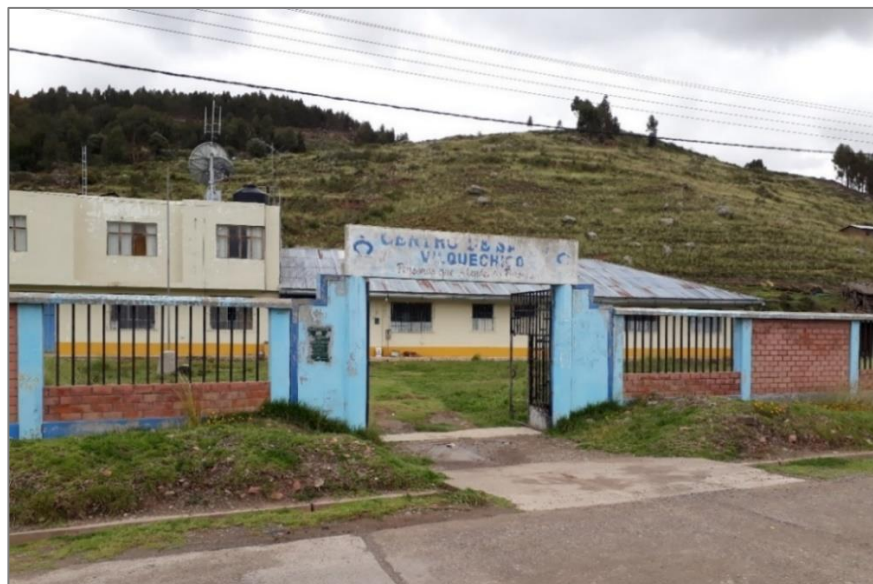
Figura N° 73: Ingreso al Centro de Salud Vilquechico I-4 Fuente: (Elaborado por el equipo de trabajo)
