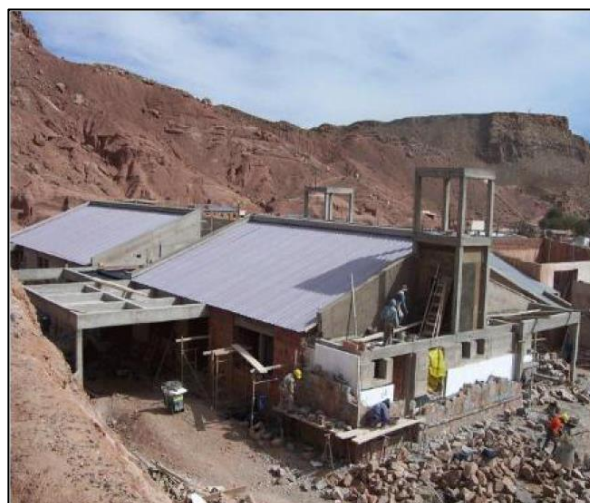
Figura N° 46: Construcción muro doble con aislante térmico.
