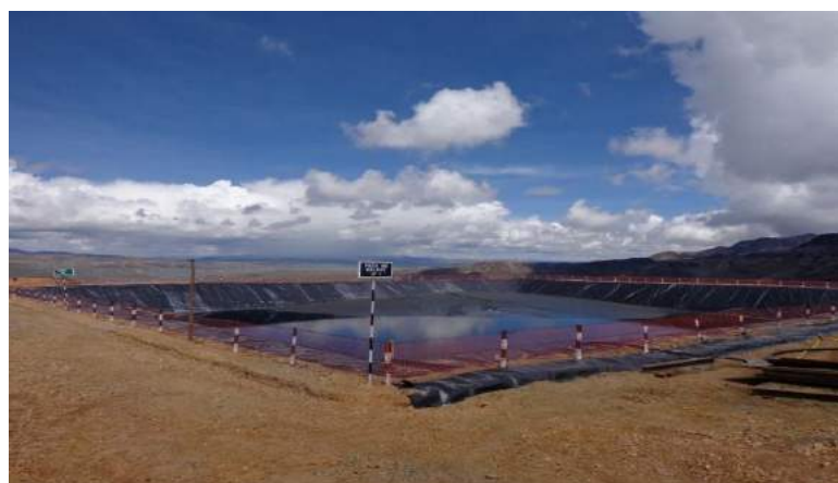
Figura 9. POZA RELAVERA DE LA PLANTA ACTUAL
