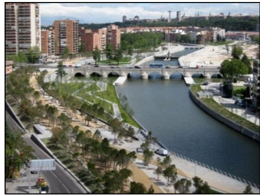
Figura 16: Puente de Segovia
