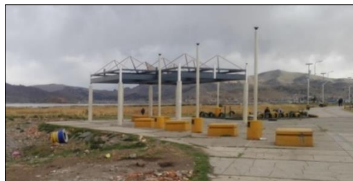
Figura 117: Mobiliario en deterioro
