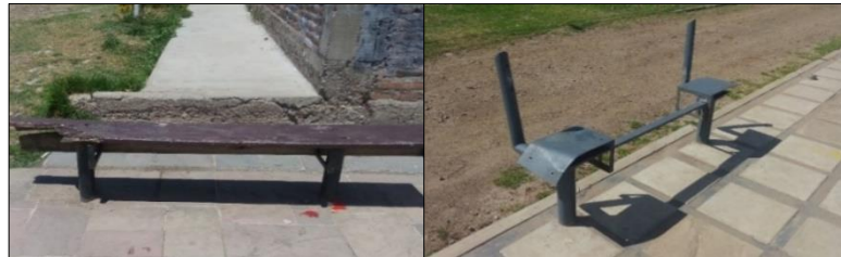
Figura 97: Estares en deterioro
