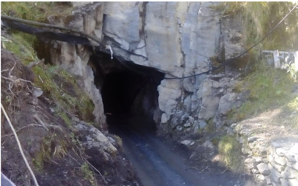
Figura 17. Afloramiento de la roca metamórfica en la bocamina.
