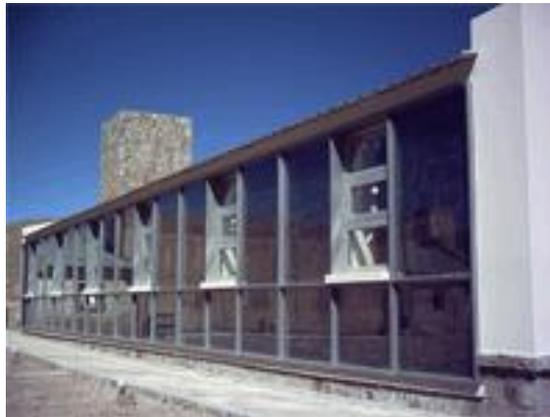
FIGURA 22: Fachada Norte con Muros Colectores
