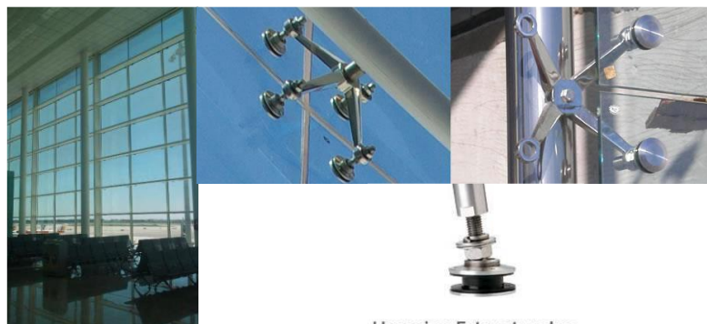
Figura 50: Pie de Vidrio – Herrajes Estructurales.
