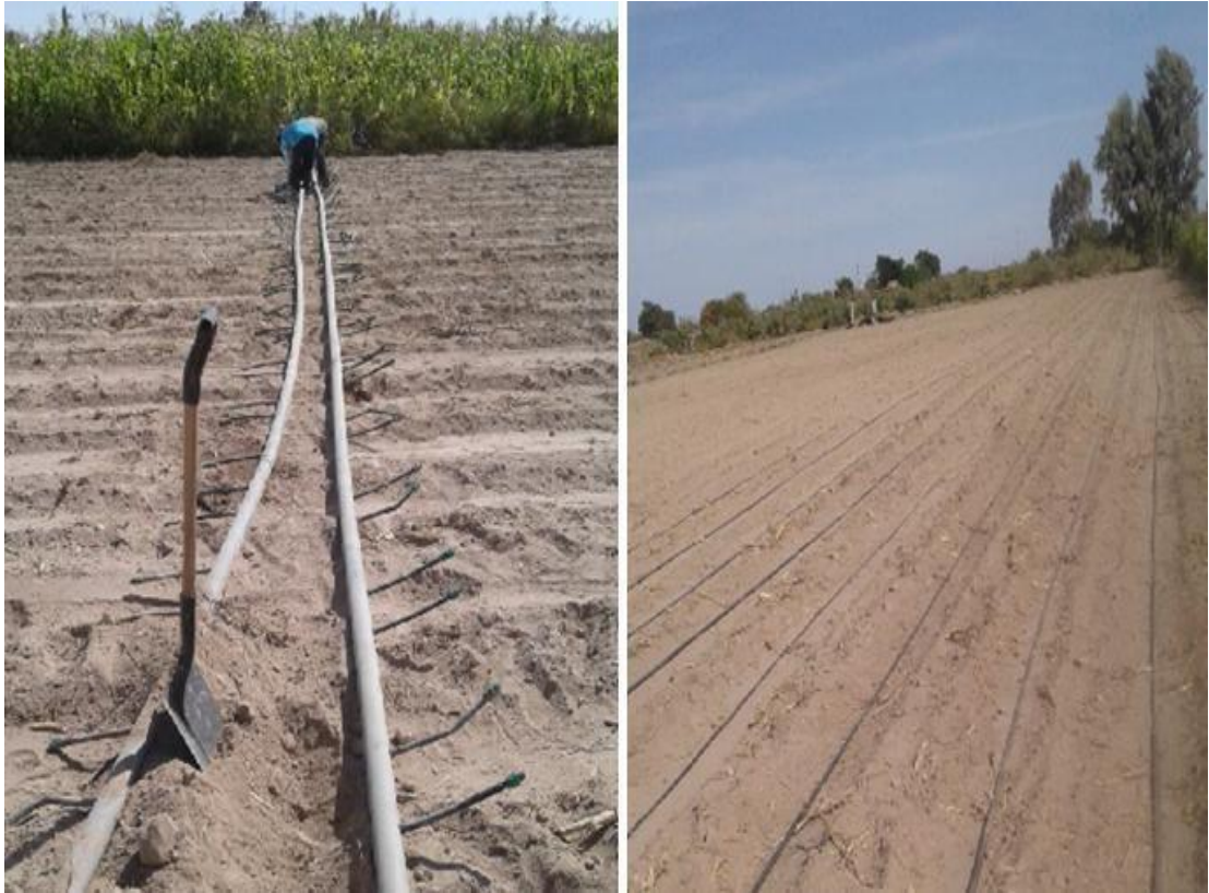
Foto 3. Instalación de tubos PVC de sistema y cinta de riego.
