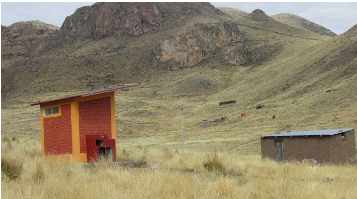
Figura 18. Instalación de letrina por el Ministerio de Vivienda en la comunidad de Ingenio Huacullani
