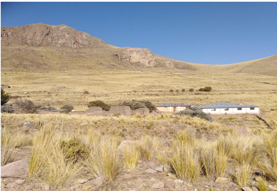
Figura 20. Oficina principal del proyecto minero Bear Creek Mining Company en Ingenio
