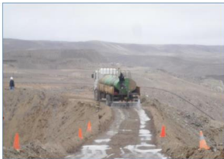
Figura N° 8: fotos de inicio de construcción de las relaveras
