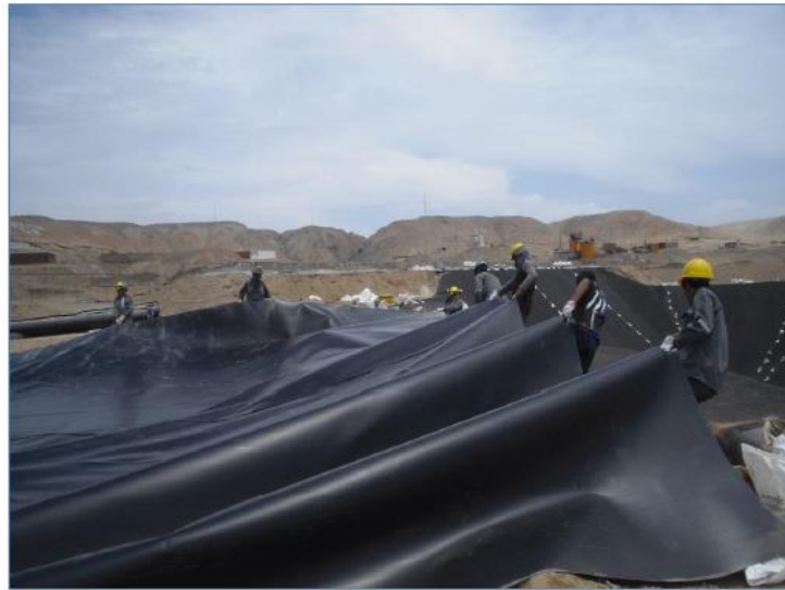
Figura N° 11: Vista de forrado con geomembrana
