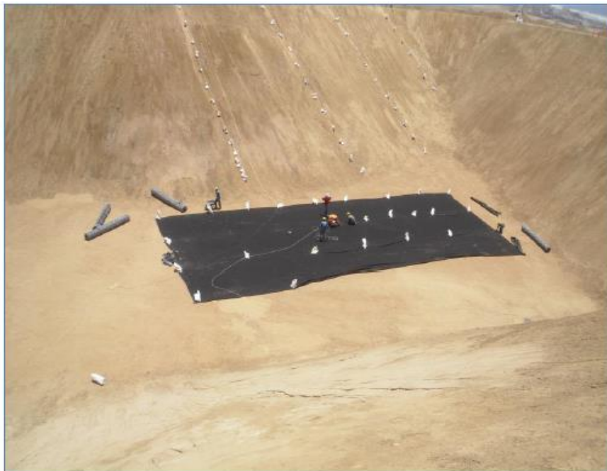
Figura N° 10: Vista del proceso de Forrado con geotextil
