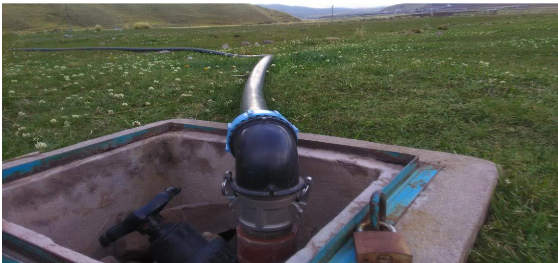
Fotografía 9: Válvula de paso del hidrante, disponible para tres mini-aspersores.
