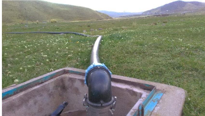
Figura 13: Lateral de riego, de tubería PE de 63mm.
