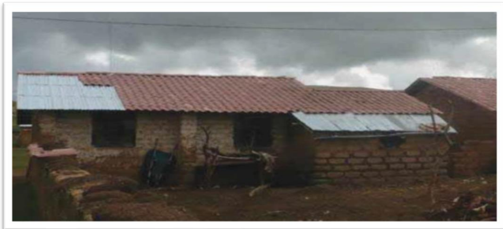
Figura 8: Casa de adobe.
