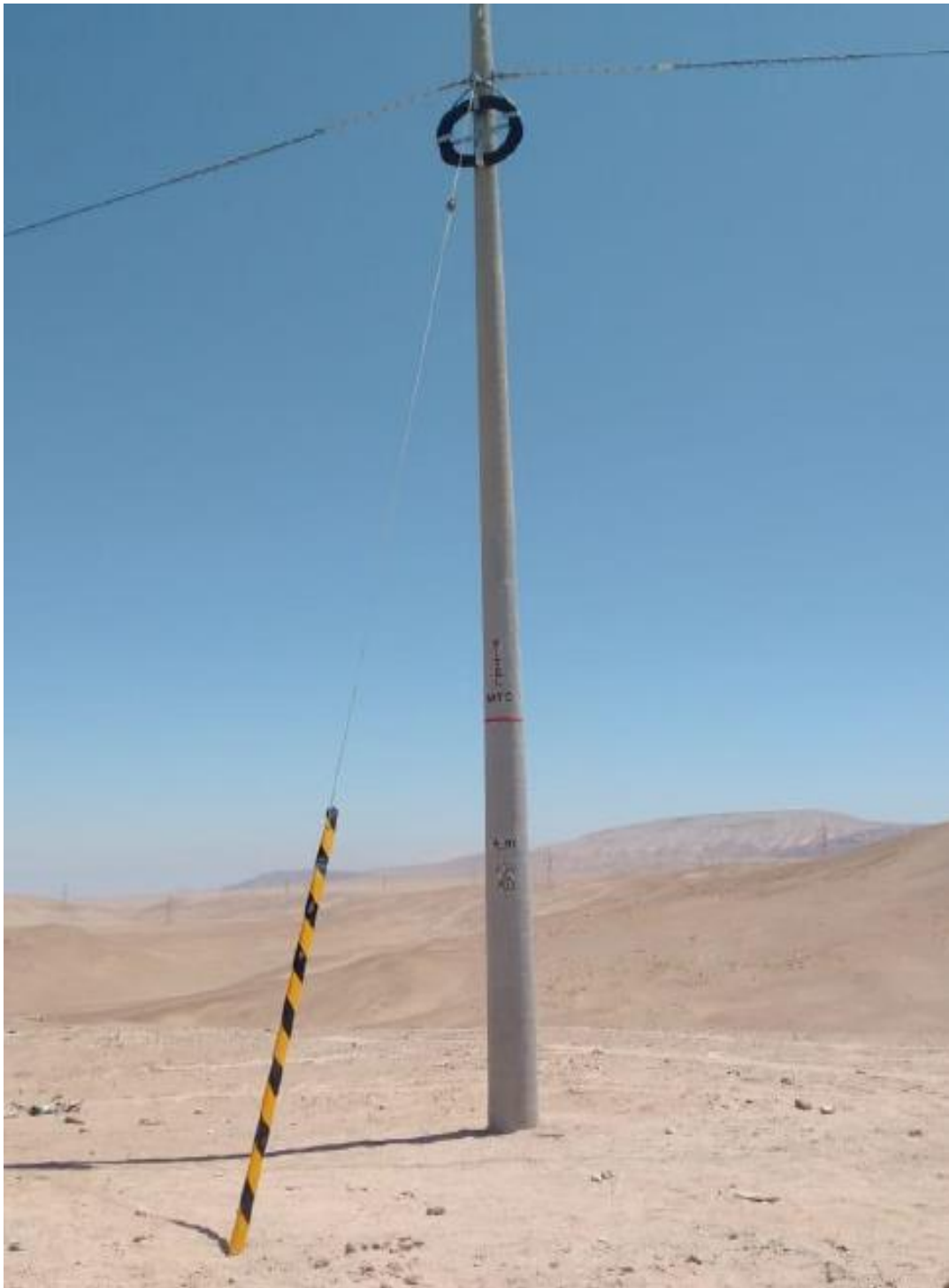
Figura 36. Retenida instalada.
