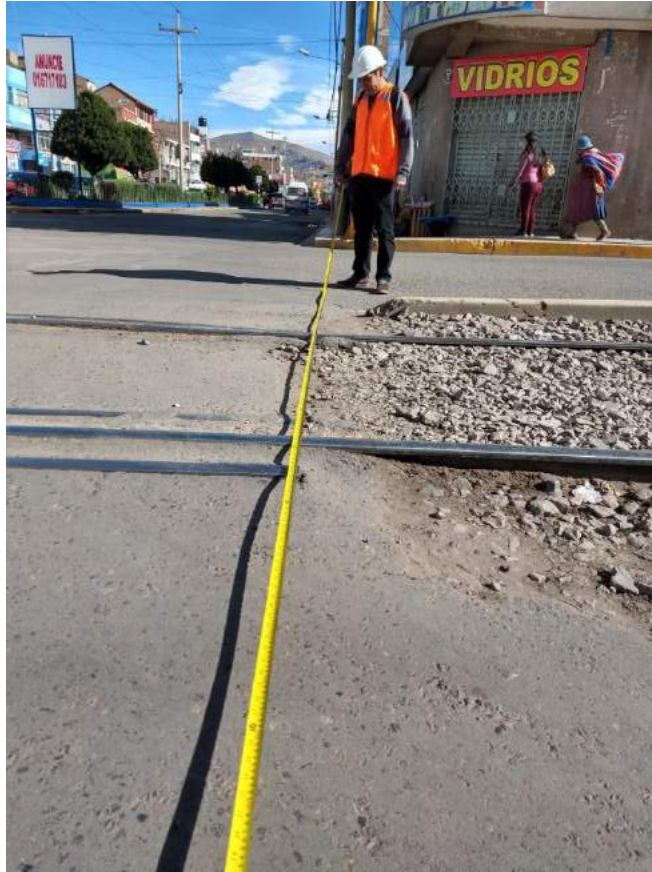
DESPRENDIMIENTO DE AGREGADOS
