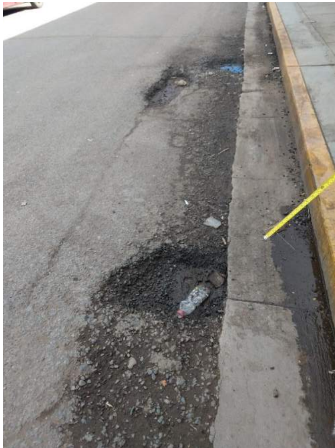
DESPRENDIMIENTO DE AGREGADOS
