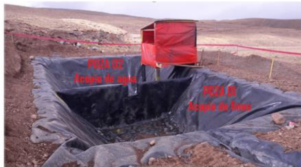
Figura 4 Construcción de pozas con geomembrana
