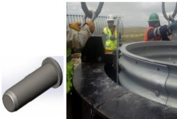
Figura 10 Colocado de anillos para la chimenea
