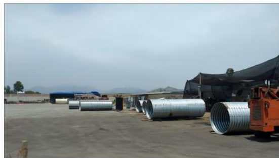
Figura 2 Anillos de acero corrugado
