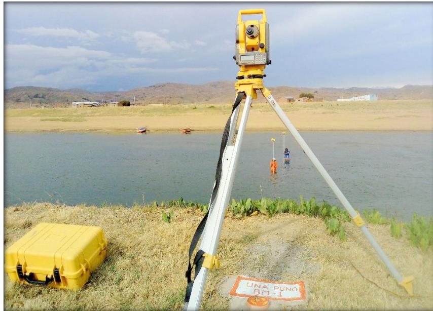
Figura N° 14: Estacionamiento en BM - 1
