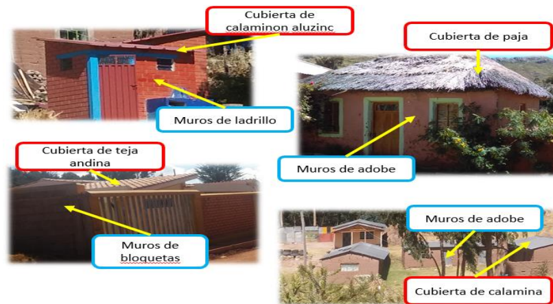
Figura 4. 10. Materiales utilizados en las vivienda-hospedaje de Escallani
