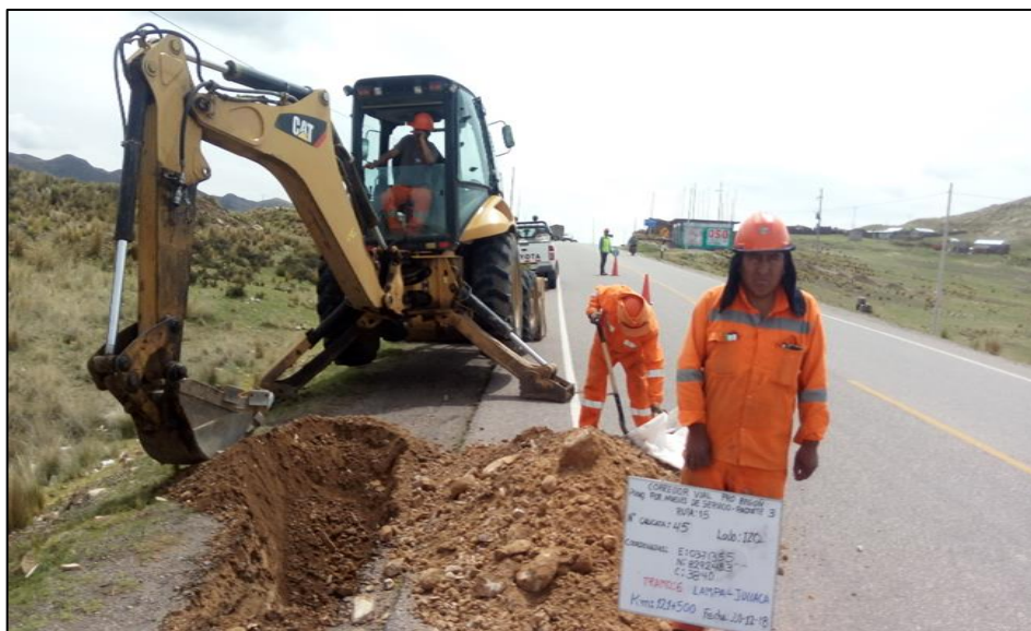
Figura 17. Ensayos destructivos (calicata)
