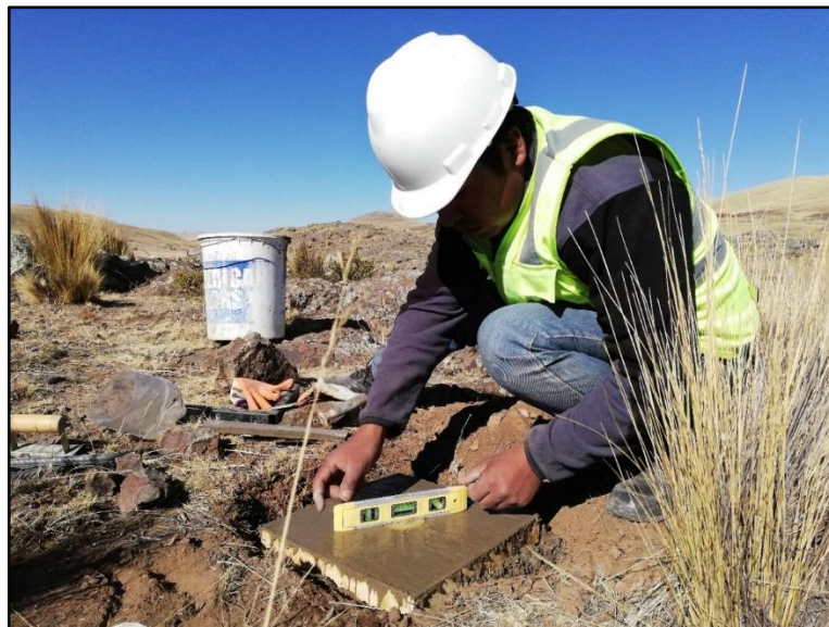
Fotografía N° 2: Nivelación de Placa del Punto CRL - 01
