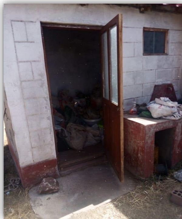
Figura 9: Vista general en las condiciones que se encuentra las Unidades básicas con arrastre hidráulico (UBS-AH), ejecutado en la segunda etapa
