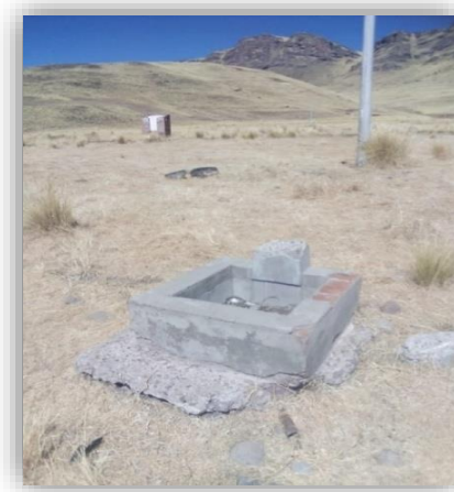
Figura 6: Pileta ejecutado en la primera etapa
