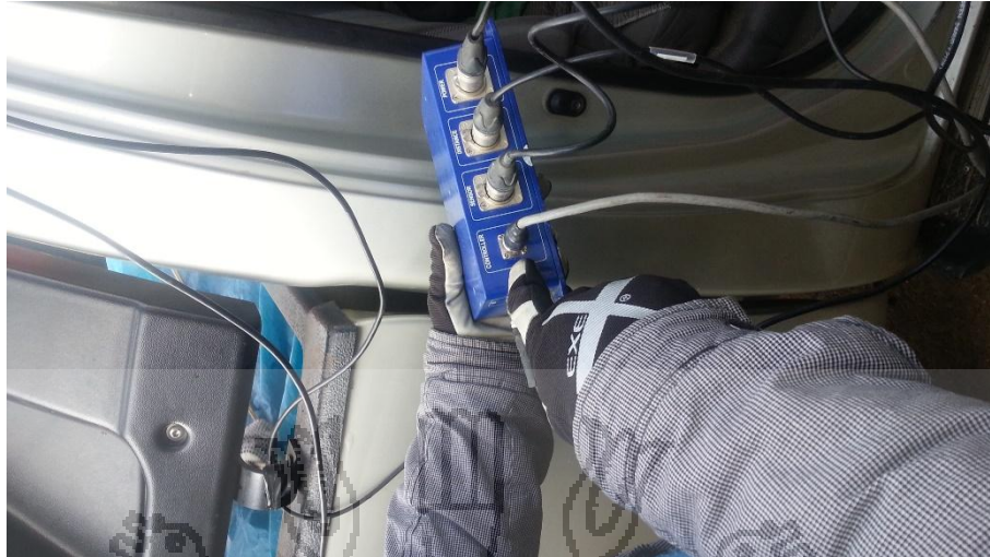
Fotografía 07. Fuente de alimentación del Equipo.
