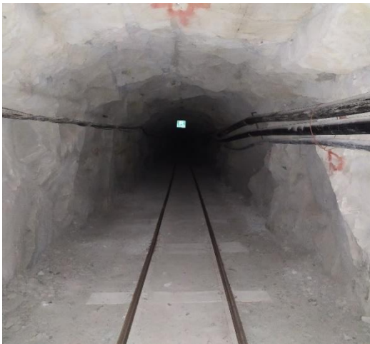
Figura 4. Nuevo Acceso a mina.
