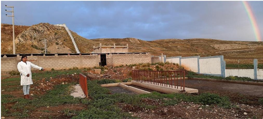
**Figura 15.** Planta de tratamiento de lodos en mal estado
