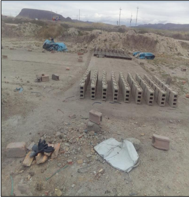
Materia Prima Depositado de Arcilla y Tierra
