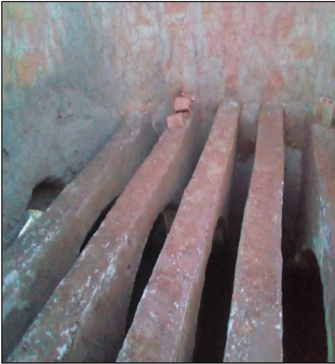
Los Arcos del Horno de Carga
