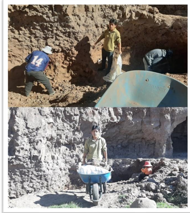
Figura 30 Extracción de arcilla de cantera Rinconada de Salcedo
