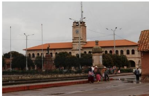
Figura 18 Biblioteca Municipal De Lampa.
