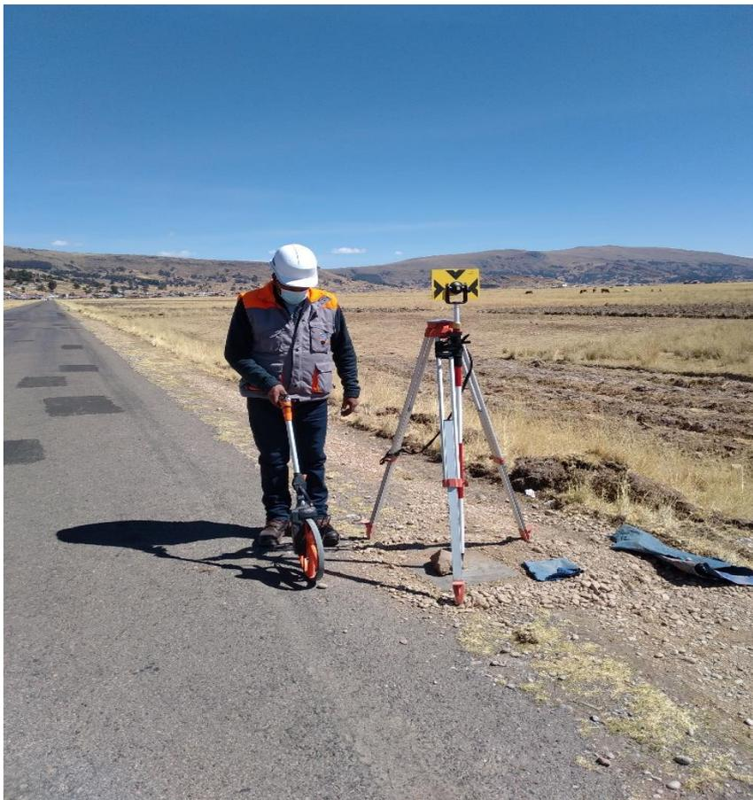
*Figura 33. Medición de base con equipo odómetro digital*
