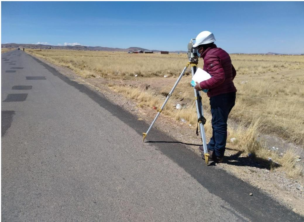
*Figura 32.* Medición de base con equipo teodolito electrónico
