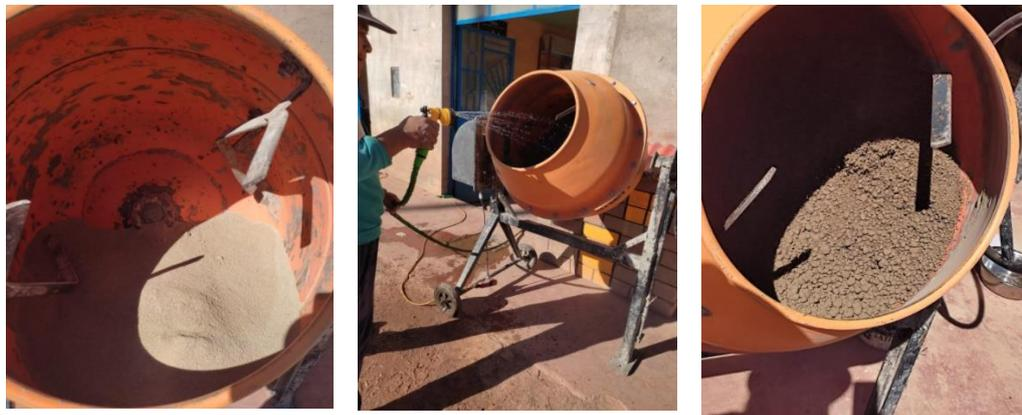
**Figura 19:** Mezcla en proceso de homogeneización.
