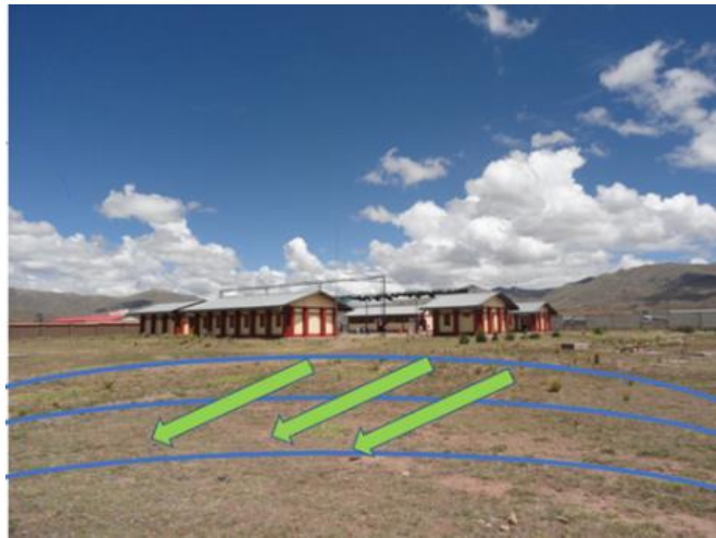
Esquema 16. Pendiente mínima del terreno 4 %.
