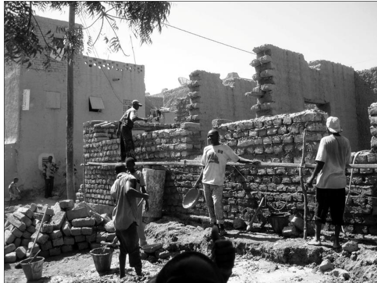
Figura N° 7. Construcción de una escuela en Mopti (Mali) mediante adobes de barro de gran formato.
