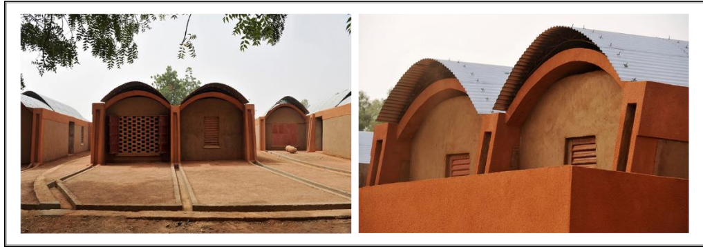
Figura N° 15. Imágenes reales de los módulos y sus cubiertas.
