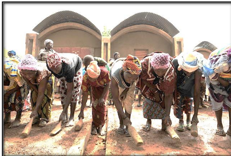
Figura N° 16. Construcción con habitantes propios de la zona.
