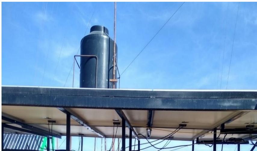
**Figura 4.5:** Estructura para soporte de paneles solares
