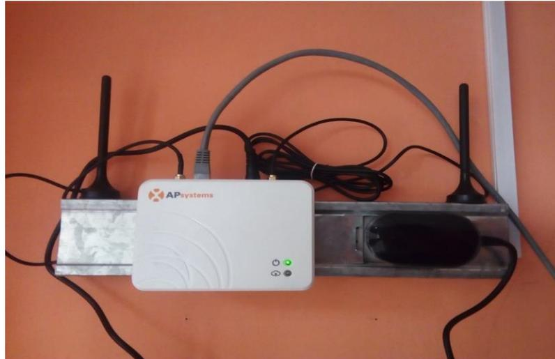
**Figura 4.9:** Instalación de la unidad de monitoreo ECU-R
