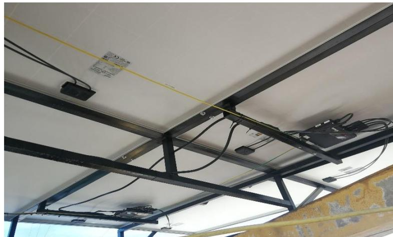
**Figura 4.7:** Instalación de microinversores
