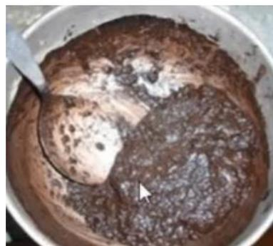
**Figura 3.20:** *Mezclado de los componentes, slurry seal tipo II*
