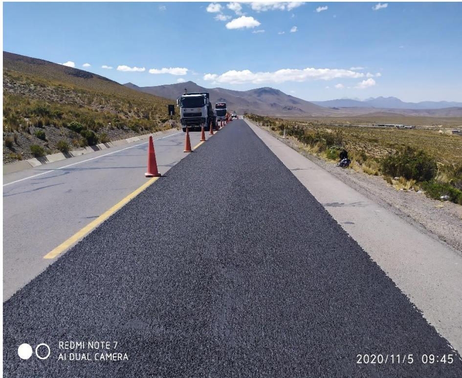
**Figura 3.44:** *Proceso de rotura de la emulsión asfáltica*
