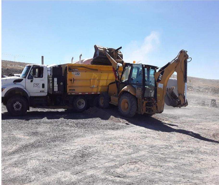
**Figura 3.40:** *Carguío de agregados a la tolva del camión micropavimentador*
