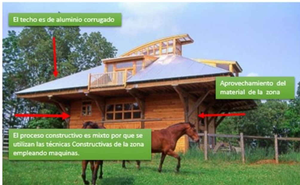
Figura 5: Materiales de construcción empleados en la casa granero americano Bolt Barn
