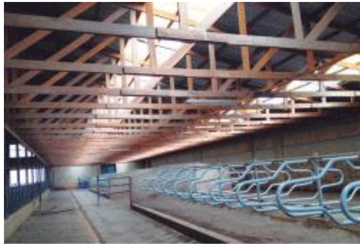
Figura 17: Estructura e iluminación natural en el galpón del Tambo Queque Norte
