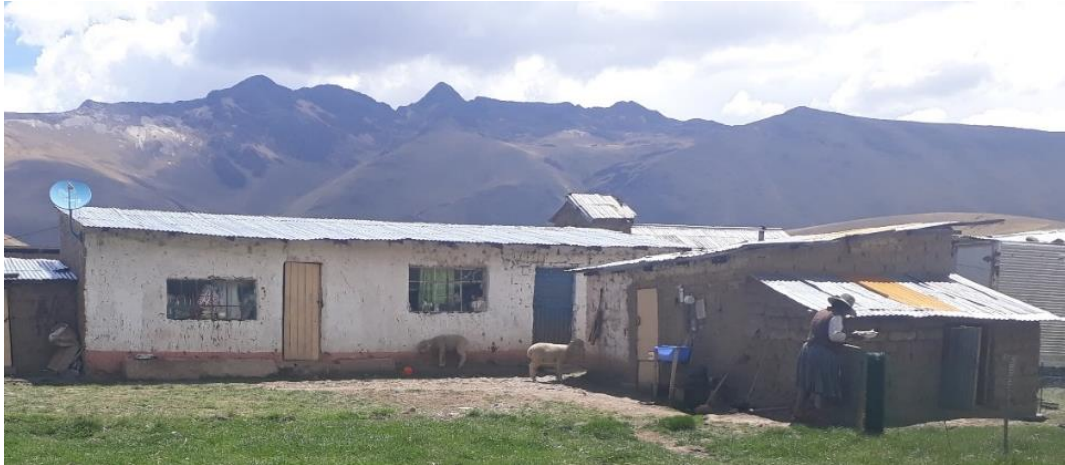
Figura 69: Puertas y ventanas en una vivienda del APA San Martín.
