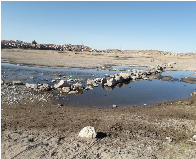
Figura 30. Paso de maquinaria pesada al río Ilave sector Churo.
