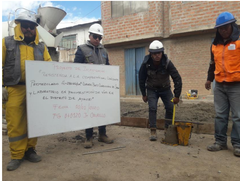
D1. Ensayo para la medición del asentamiento.
