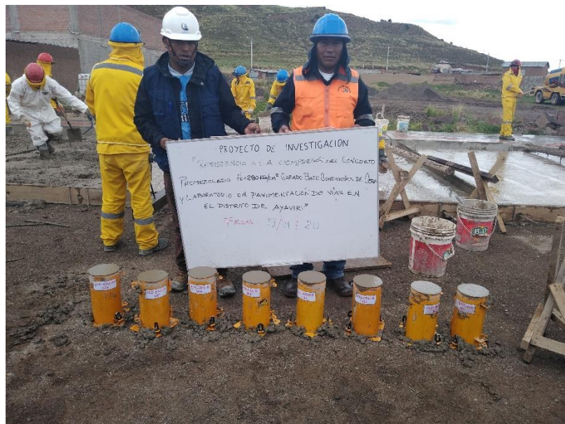
D8. Toma de muestras de concreto para curado acelerado.
