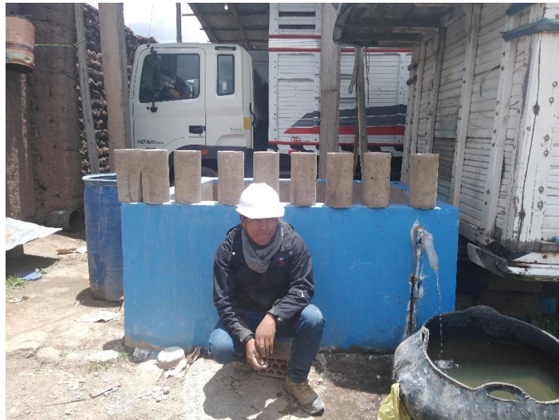
D7. Colocación de las muestras de concreto en la poza de curado estándar
