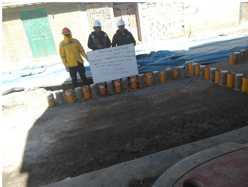
D2. Toma de 09 muestras de concreto para la condición de curado estándar (laboratorio) del primer punto.
