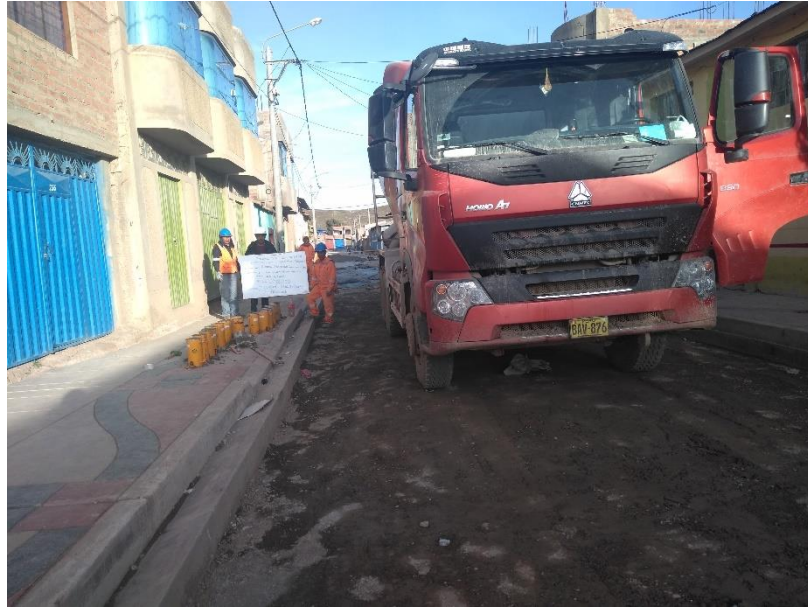
D3. Toma de 09 muestras de concreto para la condición de curado en obra del segundo punto.
