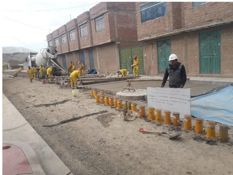
Figura 5. Toma de muestras de concreto.
