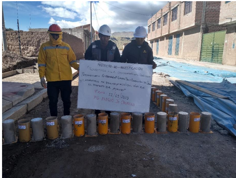
D3. Toma de 09 muestras de concreto para la condición de curado en obra del primer punto.
