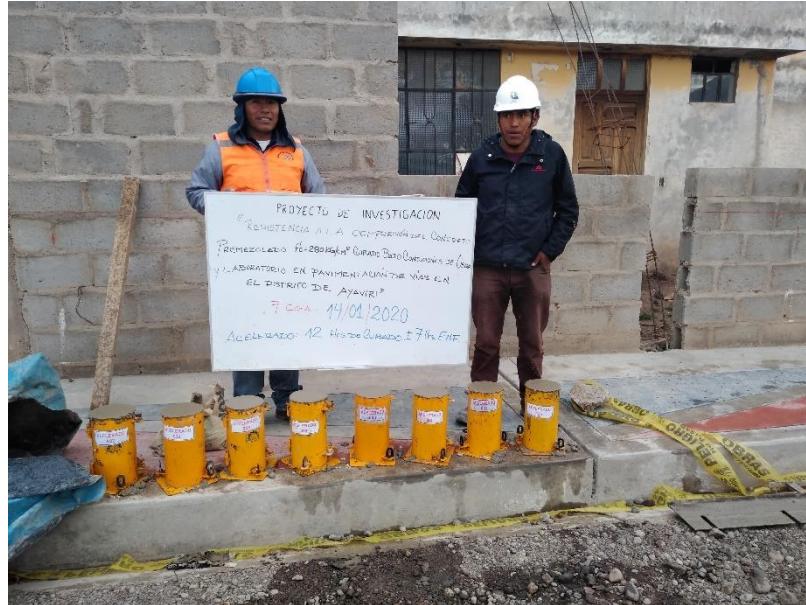
D9. Toma de muestras de concreto para curado acelerado.
