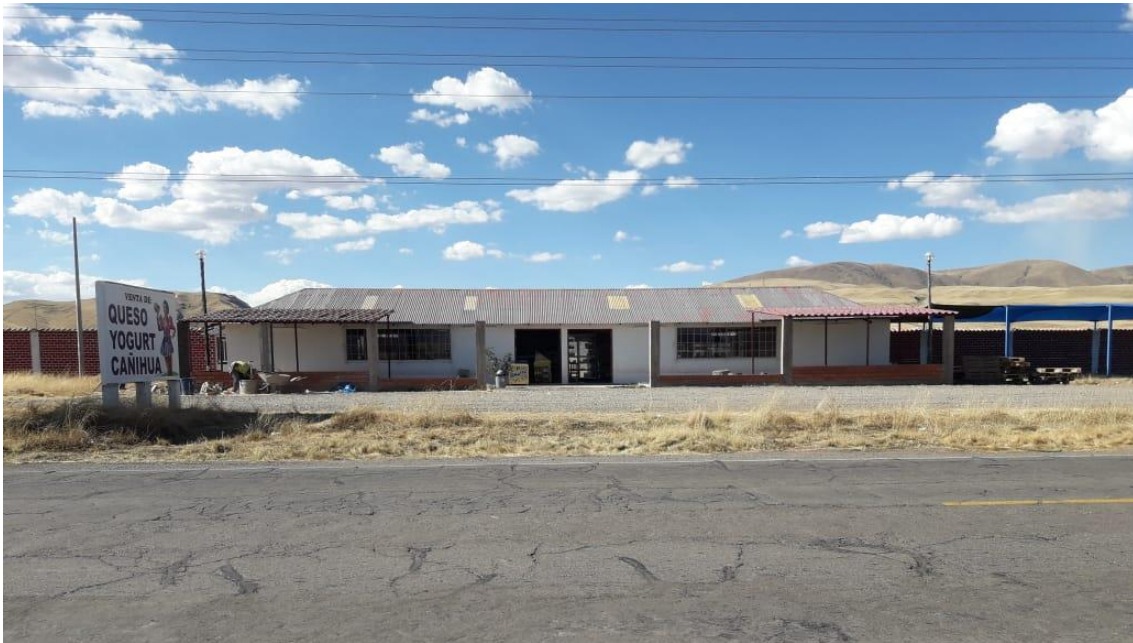
VISTA EXTERIOR DE LA PLANTA MOYANDINA
