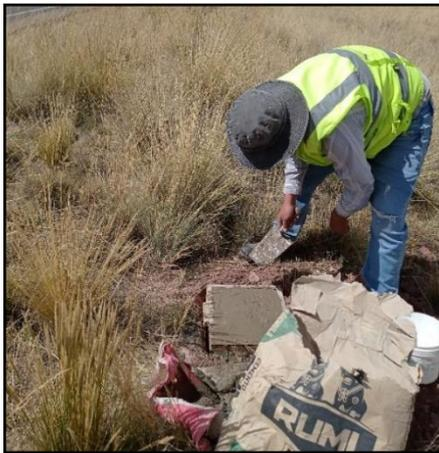
*Nota:* En la figura se muestra el encofrado y el vaciado del punto geodésico.
