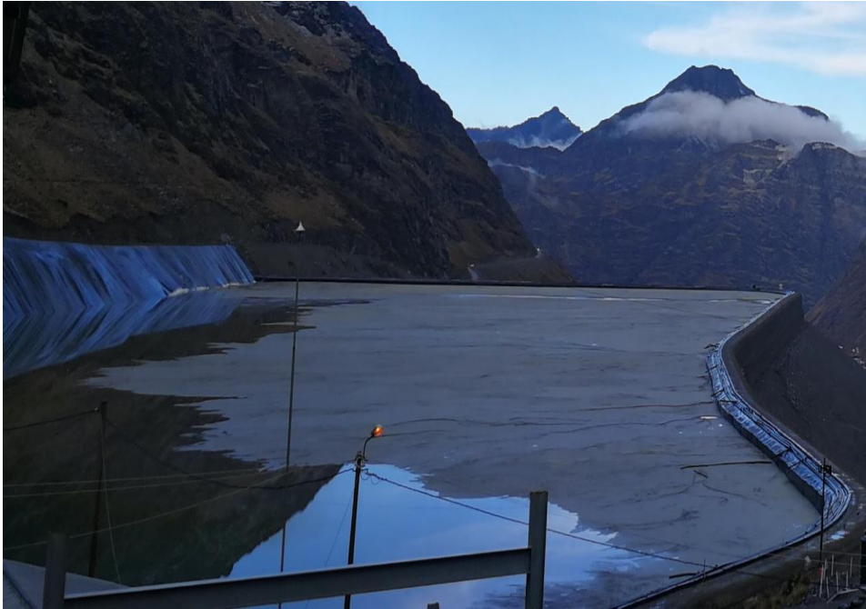
Figura 4. Presa de relaves Cori Puno.
