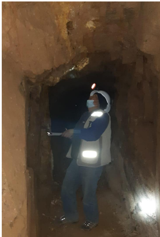
Figura 9 : Galería con dimensiones 1.20x1.80
