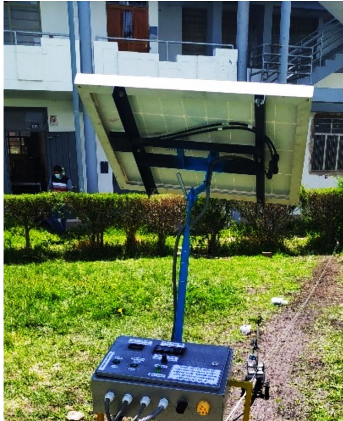
Figura N°134: Montaje del módulo fotovoltaico.
