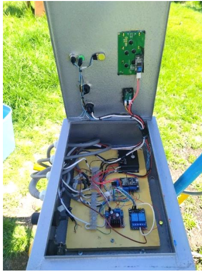
Figura N°90: Montaje de tablero eléctrico.
