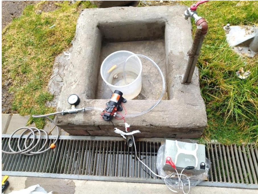
Figura N°120: Prueba de presión y caudal de la electrobomba.
