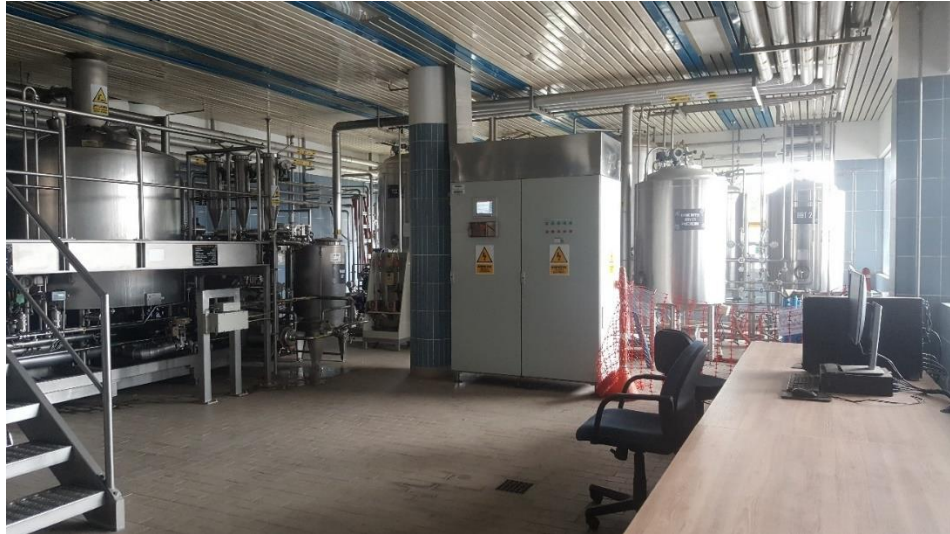
Figura A.1: Tablero de control Planta Piloto Backus-Ate.
