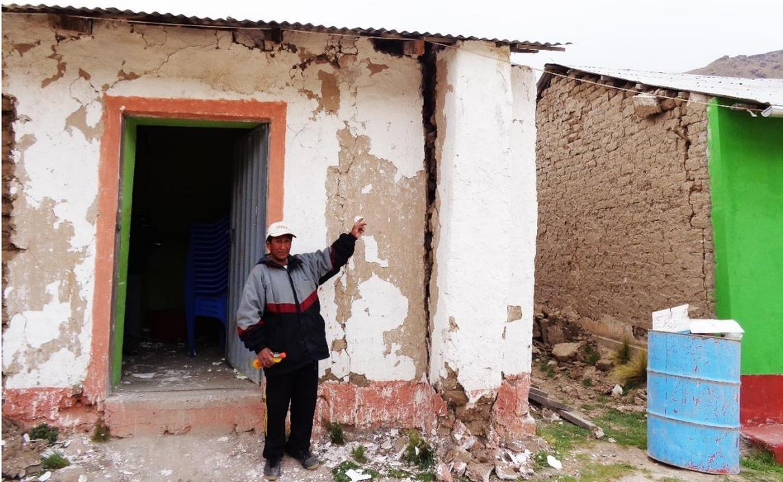
**Figura 24:** Vista de viviendas afectadas por fuertes sismos en el distrito de Ocuvi
