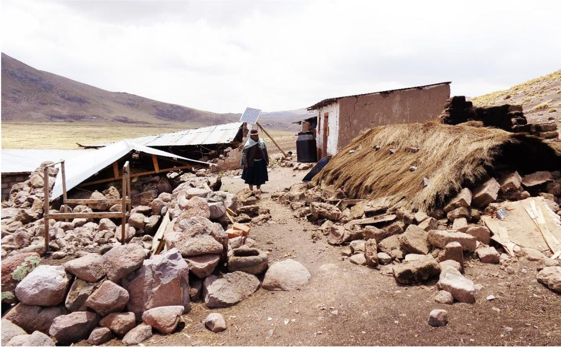
**Figura 23:** Vista de la vivienda colapsada por fuertes vientos
