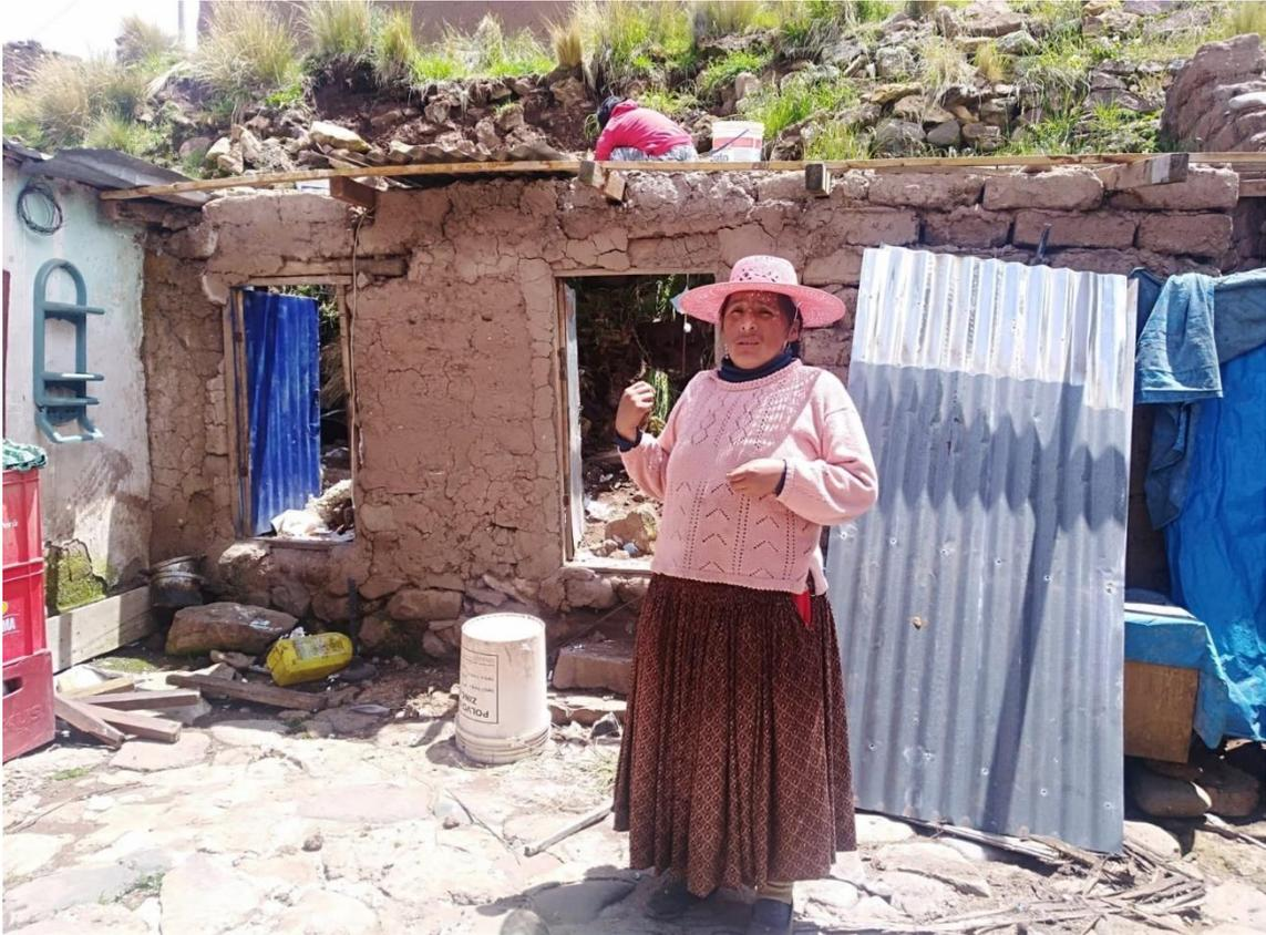
**Figura 25:** Vista de la verificación de la vivienda colapsada por fuertes vientos
