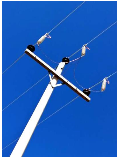
Figura N° 4. 45: Instalación de Pararrayos de línea.
